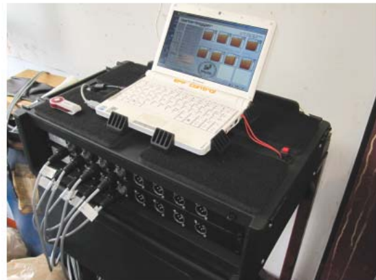
Lastmessungen in Galvanikbädern Laufzeitermittlung BHKW
